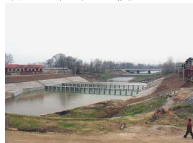
挖沟闸阻螺池（宽 60 米，长 60 米）于 2005 年 3 月竣工，可拦截携带血吸虫尾蚴的钉螺。朱江摄
